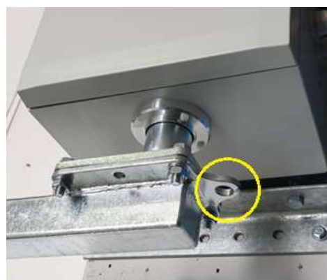
Erdungsanschluß mittels M16 Schraube
