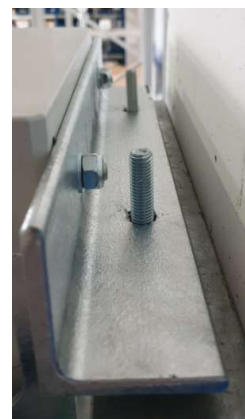
Detail hornej montážnej konzoly
