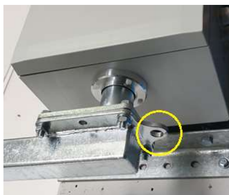
Földelési csatlakozás M16-os csavaron keresztül
