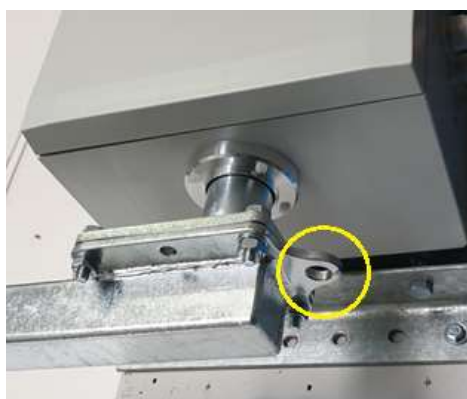
Uzemljenje putem vijka M16
