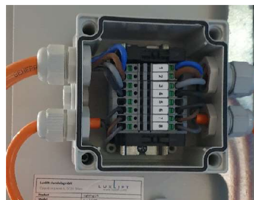
Jednoduché elektrické zapojení
